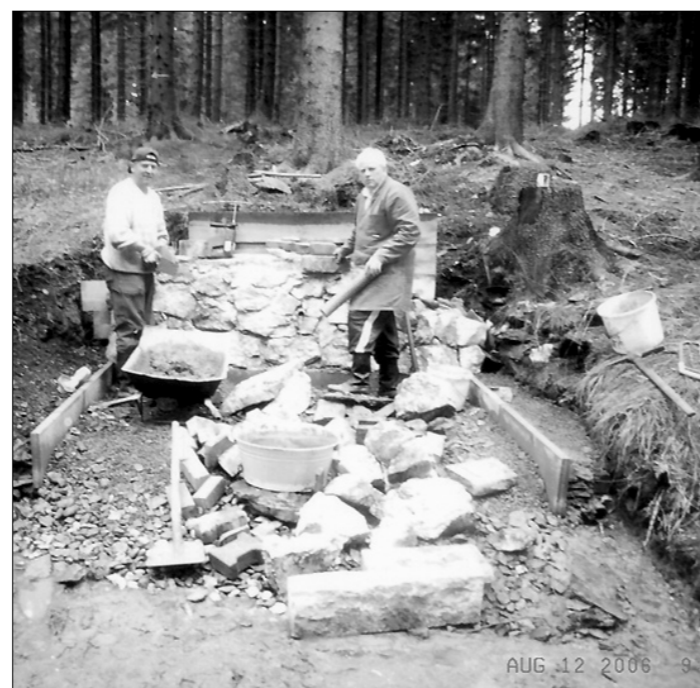
So sieht zur Zeit die Baustelle aus!
