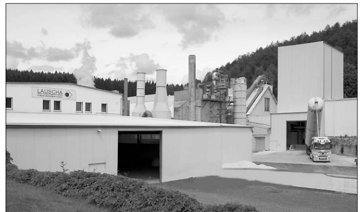
Außenaufnahme aus dem Jahr 2012 mit den technologischen Anlagen und Gemengehaus
