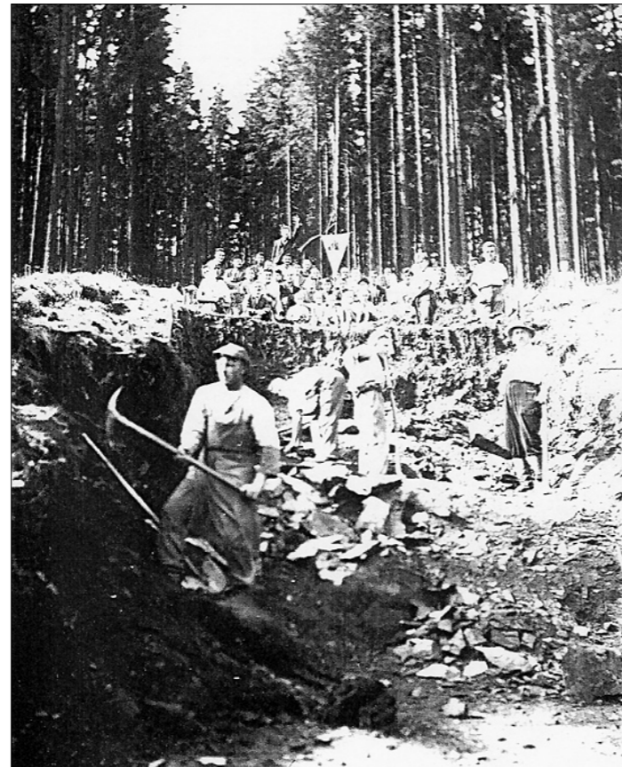
Bau der Pappenheim-Schanze Hier floss der Schweiß in Strömen ...
